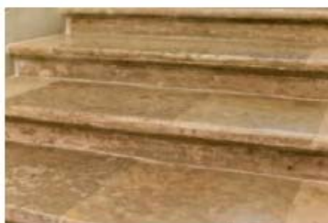
Каверны на поверхности отреставрированного пола
