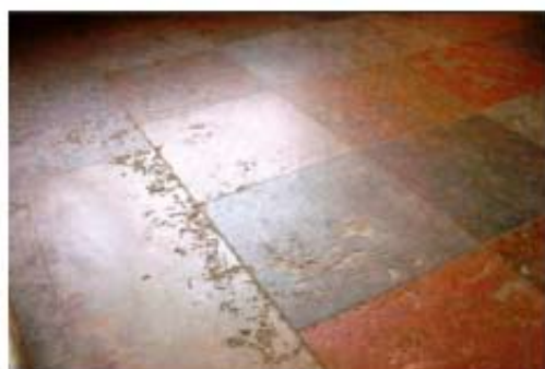
Каверны на поверхности отреставрированного пола
